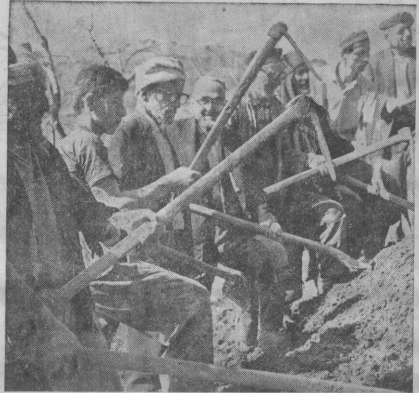
Çamlık köyünün ihtiyarları, yollarının yapımında kazma - kürek sallıyorlar.
